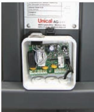
■ Sistema di regolazione temperatura, con sonda NTC
